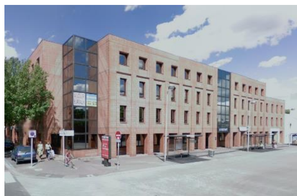
Angle des rues des Voyageurs et de la Bastide avant renouvellement (2014)
