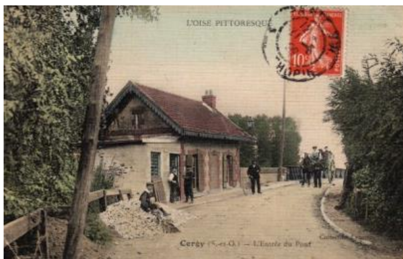
Entrée du pont de Cergy en 1900 – Étude historique, domaniale et généalogique des quartiers « Bords de l'Oise » de la Ville de Cergy
